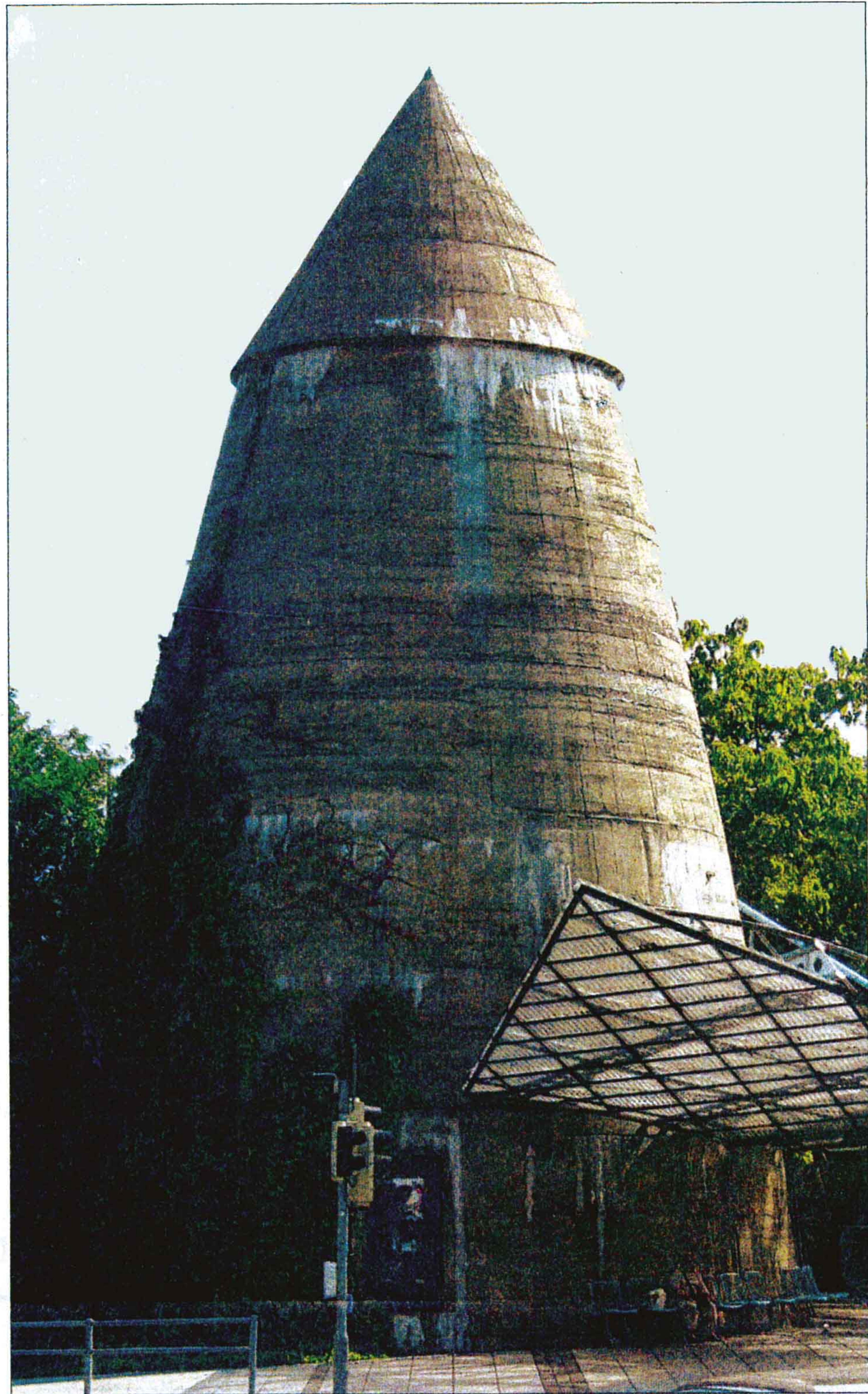
Ameisenhügel, Zuckerhut, Betonzigarre: der Spitzbunker aus dem Jahre 1939 steht unter Denkmalschutz. Nun soll er durch ein zusätzliches Dach geschützt werden. Foto: Archiv Zeyer
